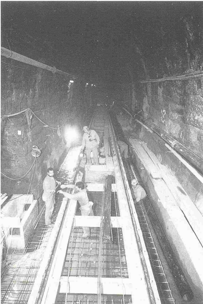
Bild 5. Zuspritzen einer Widerlagerunterfangung mit Spritzbeton
