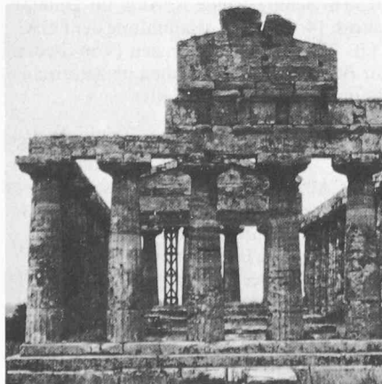
Bild 6a. Restaurierung zur Erhaltung durch Sicherung, Konservierung, Ergänzung
