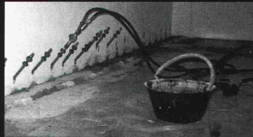
Elastische Abdichtungs-Injektion-Rascoflex in einer Zivilschutzanlage.
