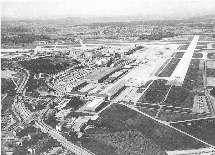
Der Flughafen Zürich von Osten (Kloten) her gesehen. Im relativ dicht bebauten Flughafengebiet gilt es vor allem, die Schadstoffintensiven Lande-Start-Phasen umweltfreundlicher abzuwickeln (Bild: Swissair, 1988)
