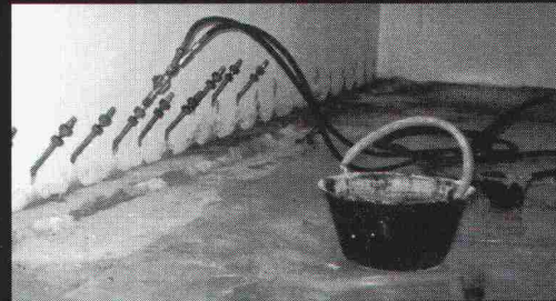
Elastische Abdichtungs-Injektion-Rascorflex in einer Zivilschutzanlage.
