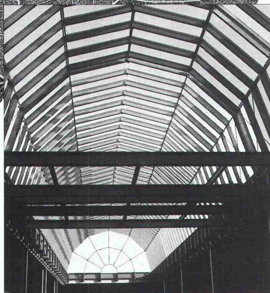
Stahl- und Industriebau
