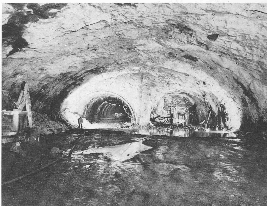
Bild 2. Kalottenausbruch in der Verzweigung. Links Haupttunnel Richtung Luzern mit Stahlbau zur Sicherung des Mittelpfeilers, rechts Beginn des Ausbruchs im Anslusstunnel
