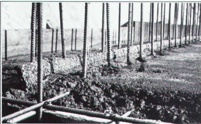
Erstellen einer Anschluss-Dichtung "BFL-MASTIX" Typ 20/70 R4.
