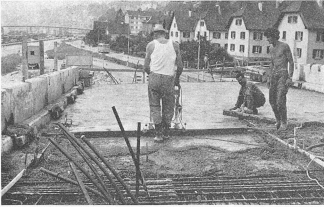
Bild 9. Man benützte die Brüstungselemente beim Betonieren der Fahrbahnplatte als Randabschalungen
