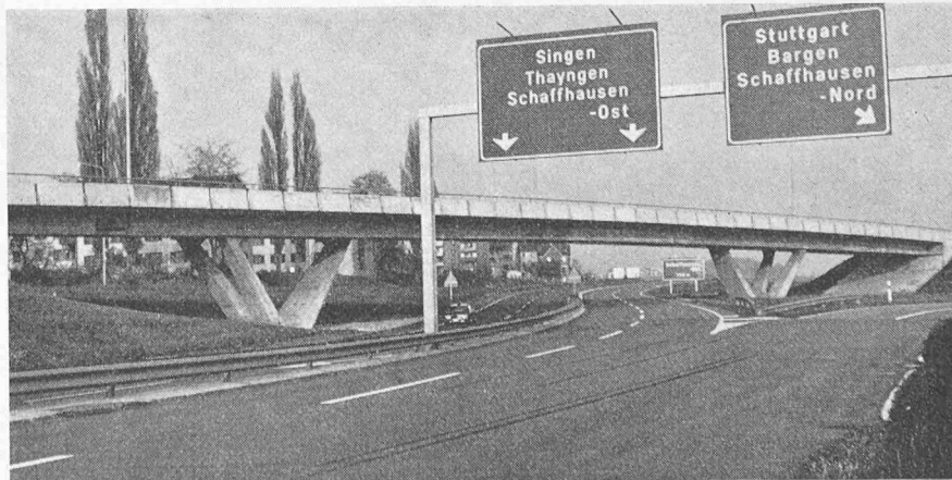
Bild 2. Ansicht der Brücke im Autobahnanschluss
