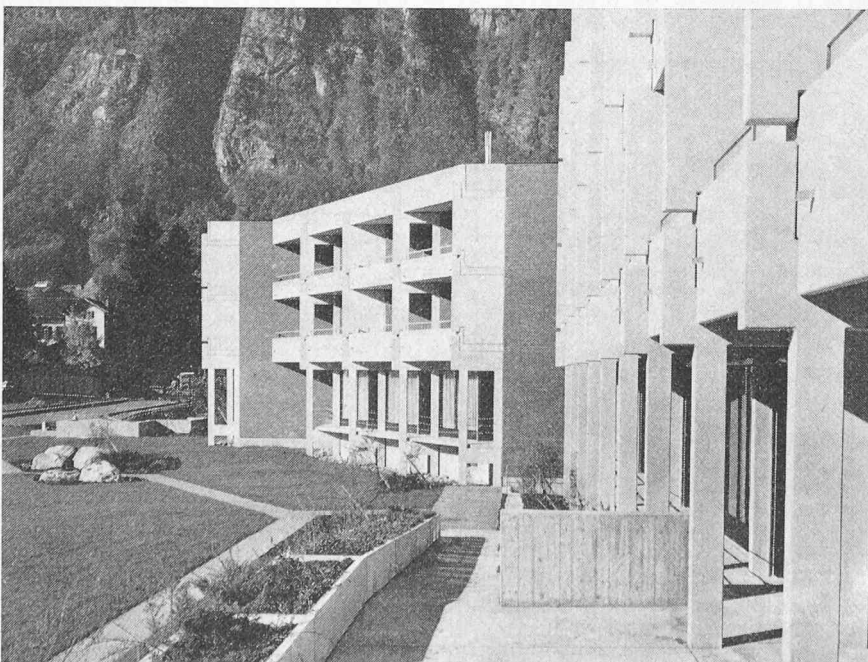
Heim- und Gemeinschaftstrakt (mit Rampe) und Wohnungstrakt von Osten
