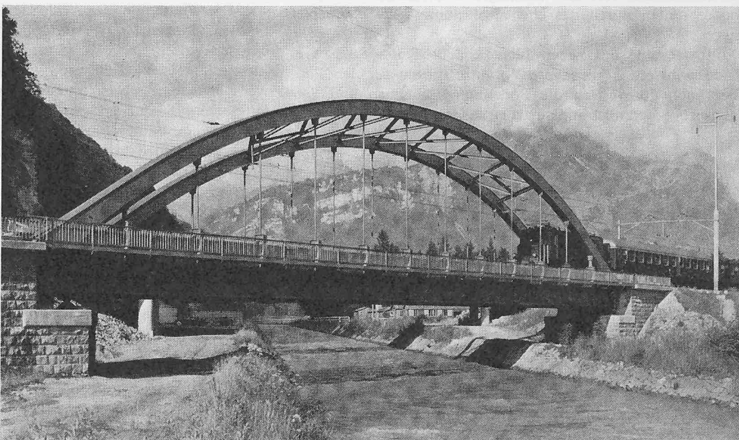
Bild 4. Gäsibrücke erbaut 1958/59, Ansicht Richtung Glarnerland
