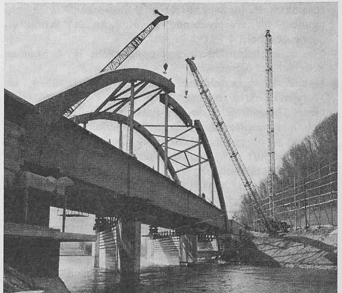
Bild 16. Montage der Biberlikopfbrücke, Einsetzen des letzten Bogen-elementes. Der Bogen ist behelfsmässig mit Montagstützen unterstellt
