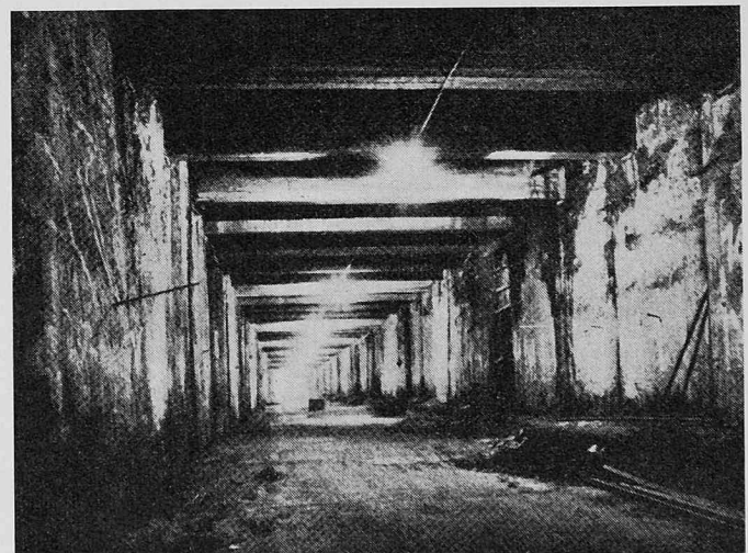
Bild 10: Tiefbahn Wien: Tunnel mit seitlichen Schlitzwänden
