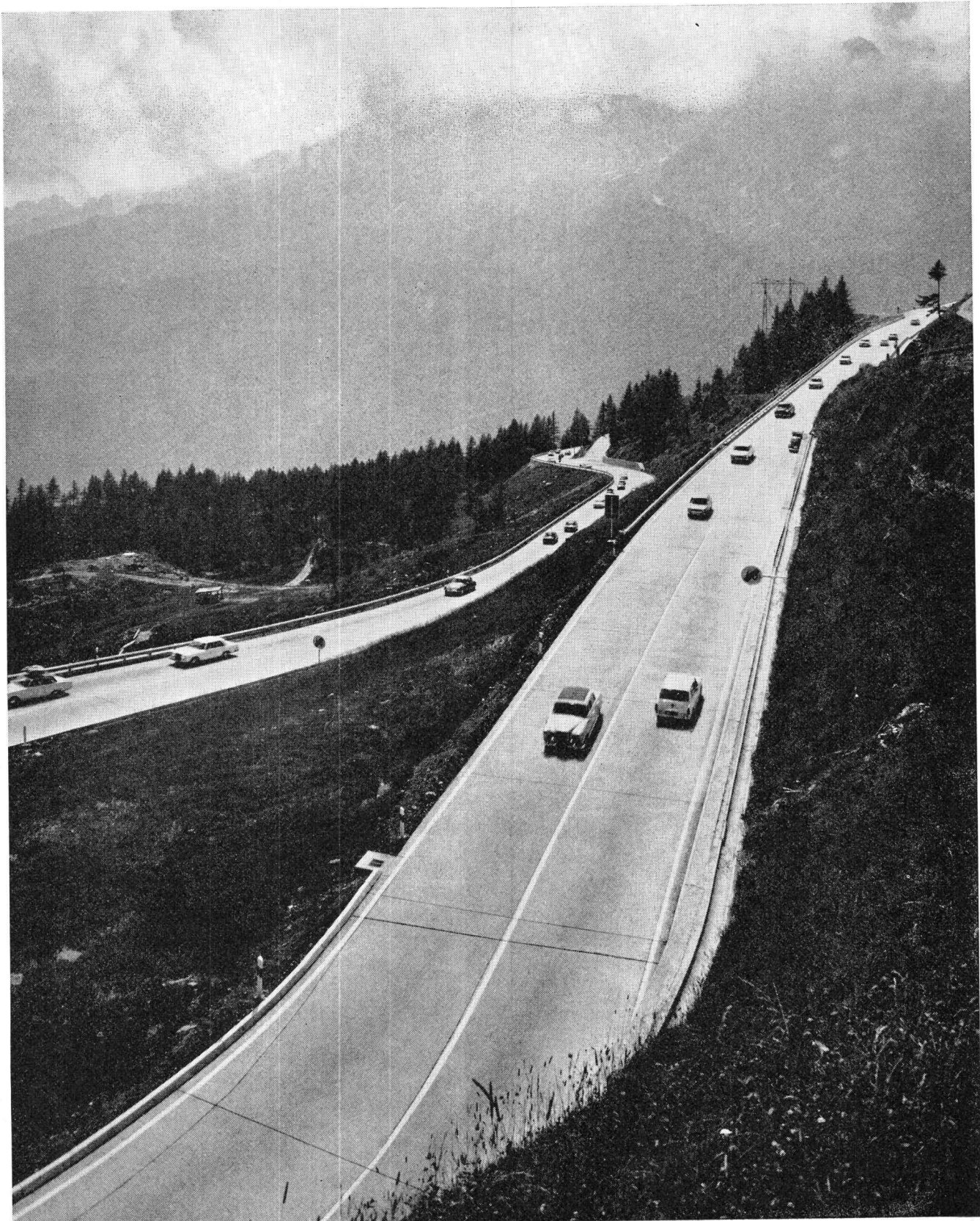
Nationalstrasse N 2 — Gotthard-Südrampe, Betonbelag
