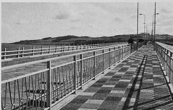
Bild 3. Fussgängerweg in Brückenmitte, farbiger Plattenbelag. Aeusseres Gelände noch unvollendet
