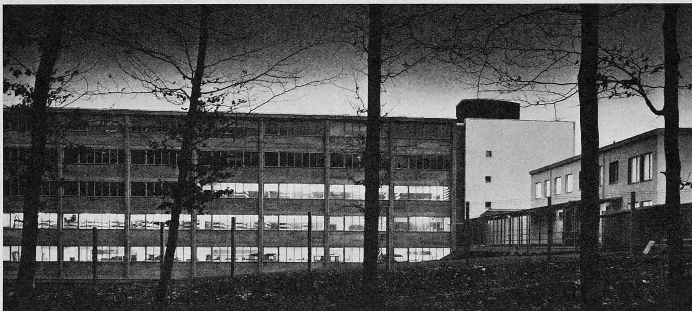
Montagehallen, Magazin und Bürohaus
