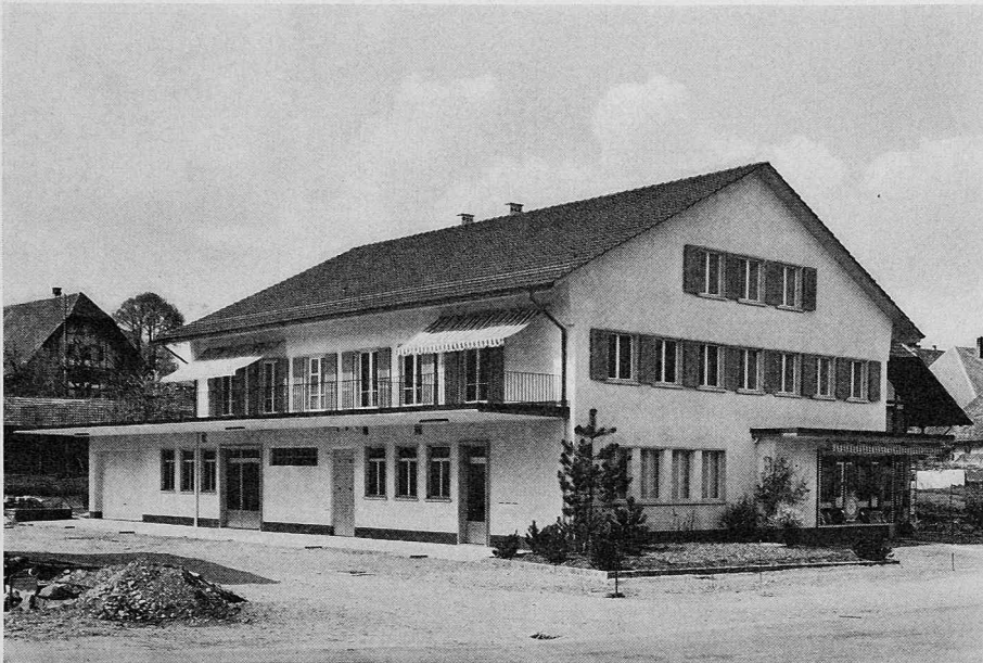
Hauptansicht mit Eingangspartie (reine Gebäudekosten 1 050 000 Fr.; Fr. 185/m 3 )
