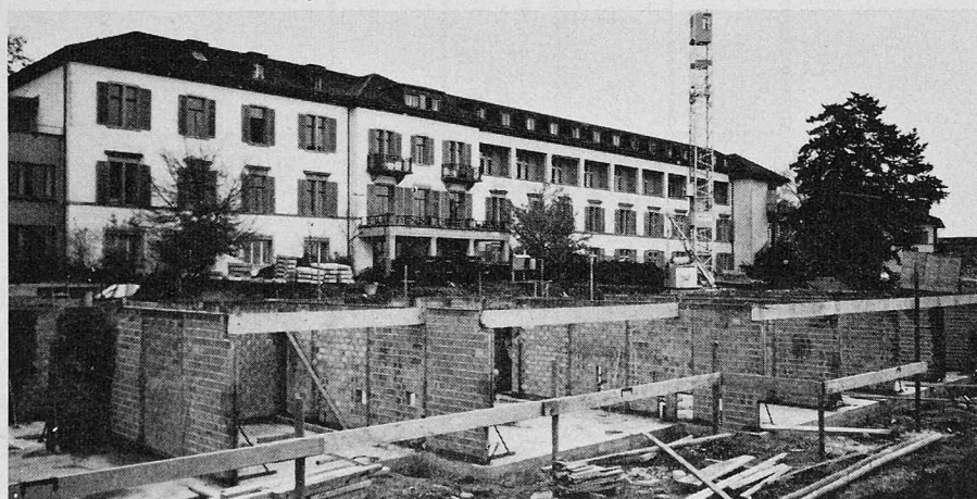
Preton-Elemente im Erweiterungsbau des Kreisspitals Männedorf
