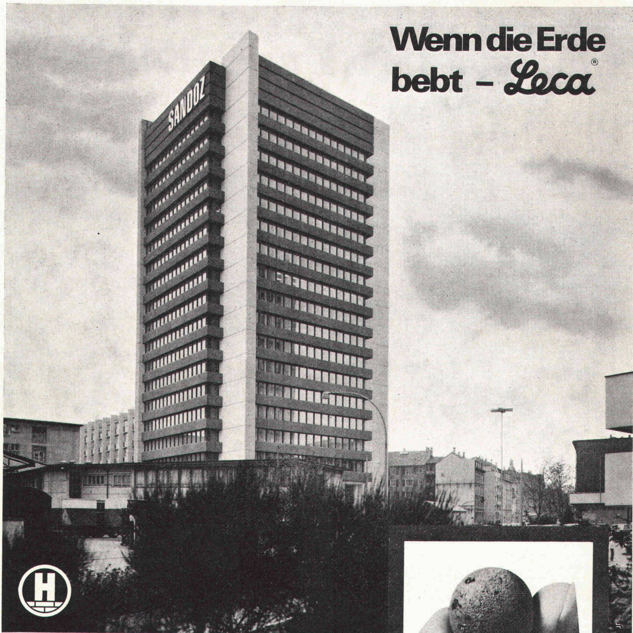
Hochhaus 210 der Firma Sandoz AG, Basel. Der Gebäudekern und die Geschossdecken bestehen aus Leca hds -Beton. Planung: Burckhardt Architekten SIA, Basel Statik: Emch + Berger, dipl. Bauingenieure ETH/SIA, Bern Bauausführung: Stamm Bauunternehmung AG, Basel
