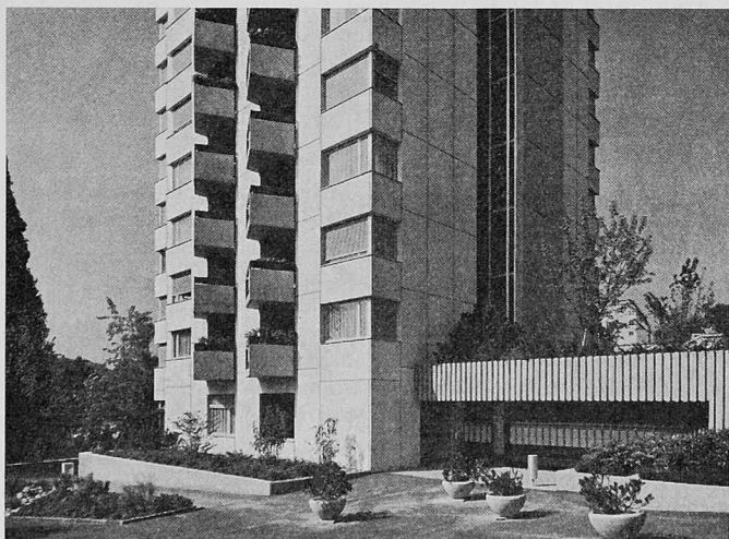
Haupteingang mit Milch- und Briefkastenanlage
