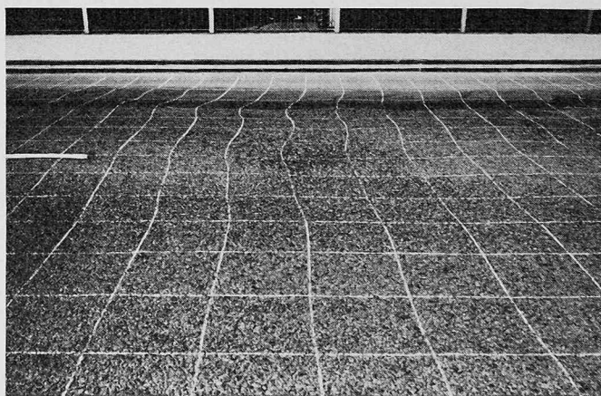
Bild 3. Schiebungen des aufgemalten Rasters innert einem Sommer (rund drei Monate)
