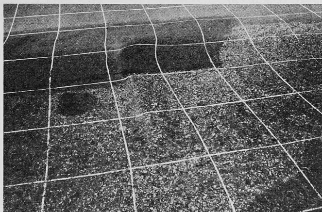
Bild 2. Wellenbildung mit aufgemaltem Raster
