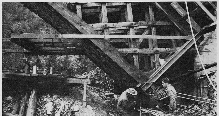
Teufelsschluchtbrücke, Freivorbau des Lehrgerüsts
