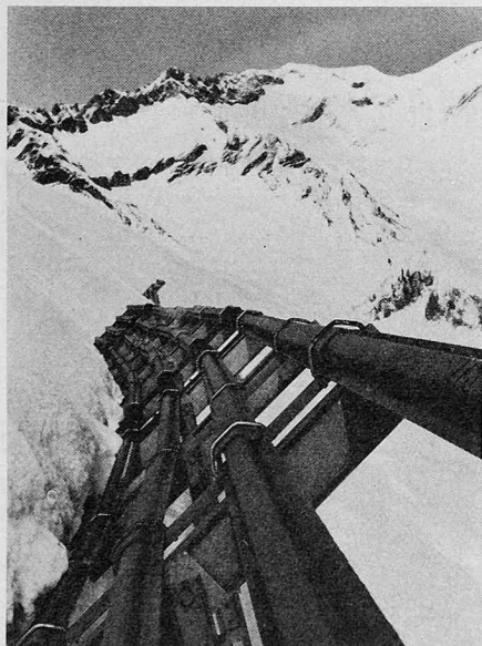
Bild 2. Stützverbauung
