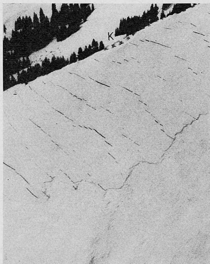
Bild 1. Im Anrissgebiet eingebaute Schneebrücken. Bei K ein Windschutzverbau gegen Gwächtenbildung
