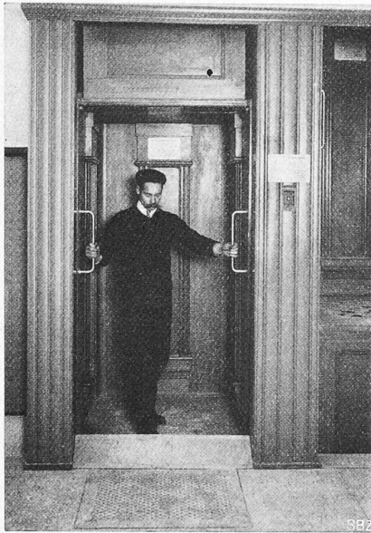
Abb. 8. Heben der Podest-Klappe (Aufahrt).
