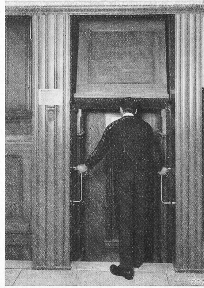
Abb. 9. Heben der Deckenklappe (Abfahrt).
