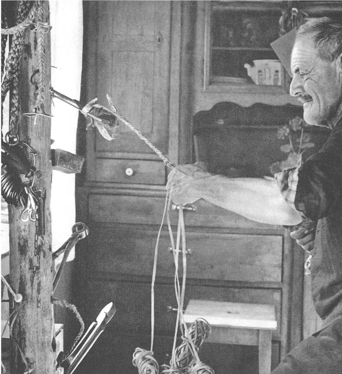
Die Zopfarbeit des Tretschenmachers Flurin Camartin in Brigels. Tretschenbaum und -haken, sowie die fünf Riemenknäuel sind gut sichtbar. (Foto: Rätisches Museum, Chur)
