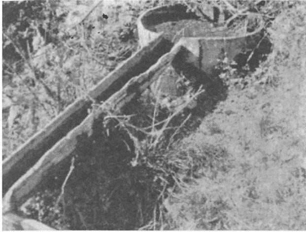
Abb. 13: Wasserfassung mit Zuleitungskanal bis zum Brunnen, Schlans
