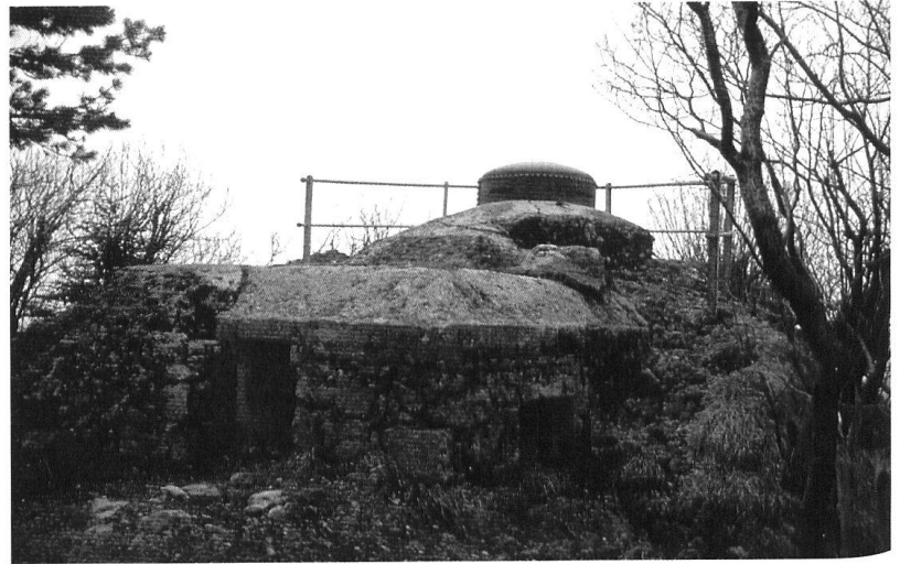
Coupole d'observation, Lauchflue, Eptingen BL, fortifications du Hauenstein. (Photo: M. L.)
