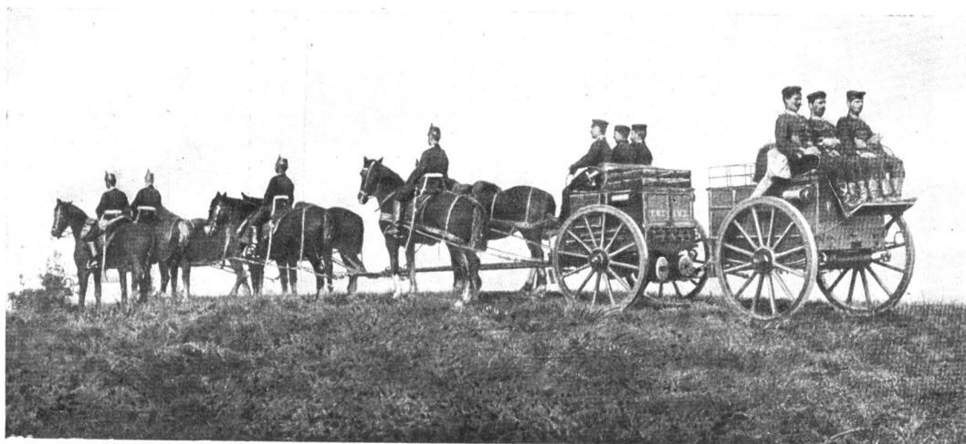
Station radiotélégraphique Siemens-Braun 1902. Station attelée.
