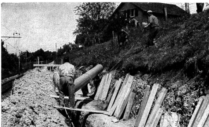
KALIDUR-Kanalisationsrohre, verlegt im Bahneinschnitt
