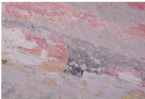
Fig. 79 Voûtain de la travée 23; phase I (1320-1330): épais filet noir en bordure de voûtain; phase II (XVI e siècle): fragments de bordures jaune et rouge; phases III et IV: traces de badigeons monochromes ultérieurs.
