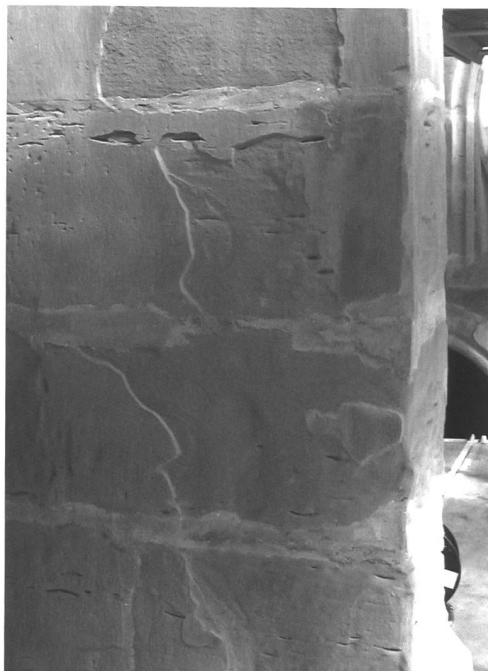
Fig. 90 Détail d'un contrefort en cours de traitement. Les surfaces ont été nettoyées par dépoussiérage et grattage des incrustations, les détachements en plaques ont été consolidés ponctuellement et les bords originaux ont été renforcés par application de solins (colmatages en biseau) à base de poudre de molasse.
