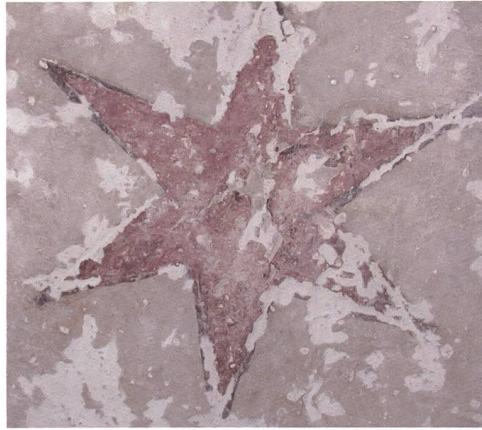
Fig. 87 Voûtain de la travée 23; étoile rouge avec incisions dans l'enduit dessinant son contour. Dans ce cas, des traces de noir sont visibles sur les bords de l'étoile, témoignant de la présence probable d'une feuille métallique, par exemple de l'argent, pour créer un effet étincelant.
