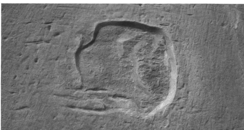
Fig. 91 et 92 Détail de la molasse extérieure avant traitement (en haut): on observe des soulèvements importants de la surface; après traitement (en bas): les éléments trop soulevés ont été éliminés, la cohérence de la molasse rétablie (bords légèrement plus sombres) et les bords renforcés par application d'un mortier à base de molasse et d'un liant aqueux à base d'un ester de silice. Abb. 90-92 Die Oberfläche des Sandsteins wurde entstaubt, Verkrustungen abgekratzt. Vollständig abgeplatzte Schalen wurden entfernt, lediglich gelöste punktuell gefestigt. Mit einem Mörtel aus wässrig gebundenem Kieselsäureester und Sandsteinmehl wurden die Ränder gefestigt und mit geböschten Kittungen gesichert.
