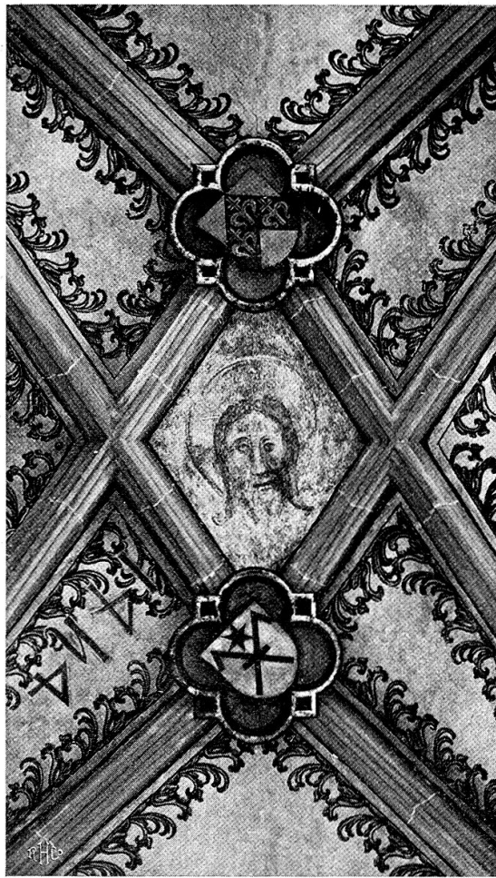
Abb. 3. Mittelpartie des Gewölbes vor der Lombachkapelle.
