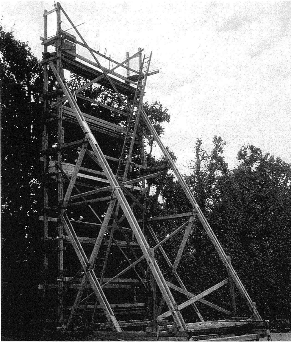
4 Wien, Schönbrunn. Gerüst für den Hecken- schnitt.
