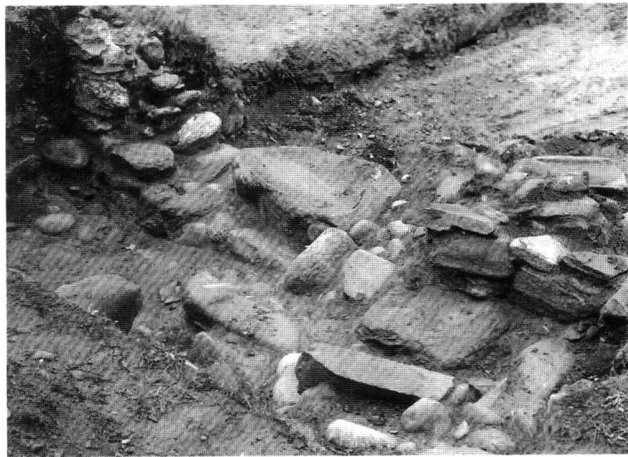
Abb. 7. Roveredo-Tre Pilastrì, Gewölberuine, Vorbau, Aufsicht von Südost.
