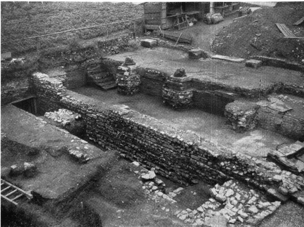
Taf. I, Abb. 2. Augst. Thermen Schwimmbassin mit Treppe der ersten Hauptperiode; später eingebaut: Säulenfundamente und westliche Abschlußmuer der Halle B (S. 31)
