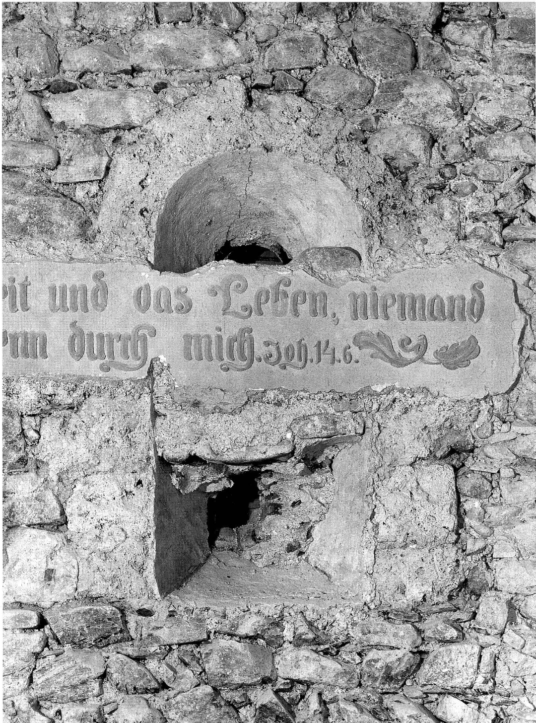
Abb. 6: Das erhaltene Fenster in der Ostmauer.
