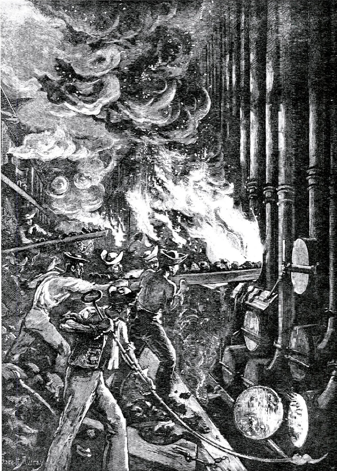
Das Füllen der Retorten in der Gasanstalt in Beckton. Illustration aus: The Illustrated London News, 1878. (Aus: Kunst und industrielle Revolution, Dresden 1974, Bild Nr. 111)
