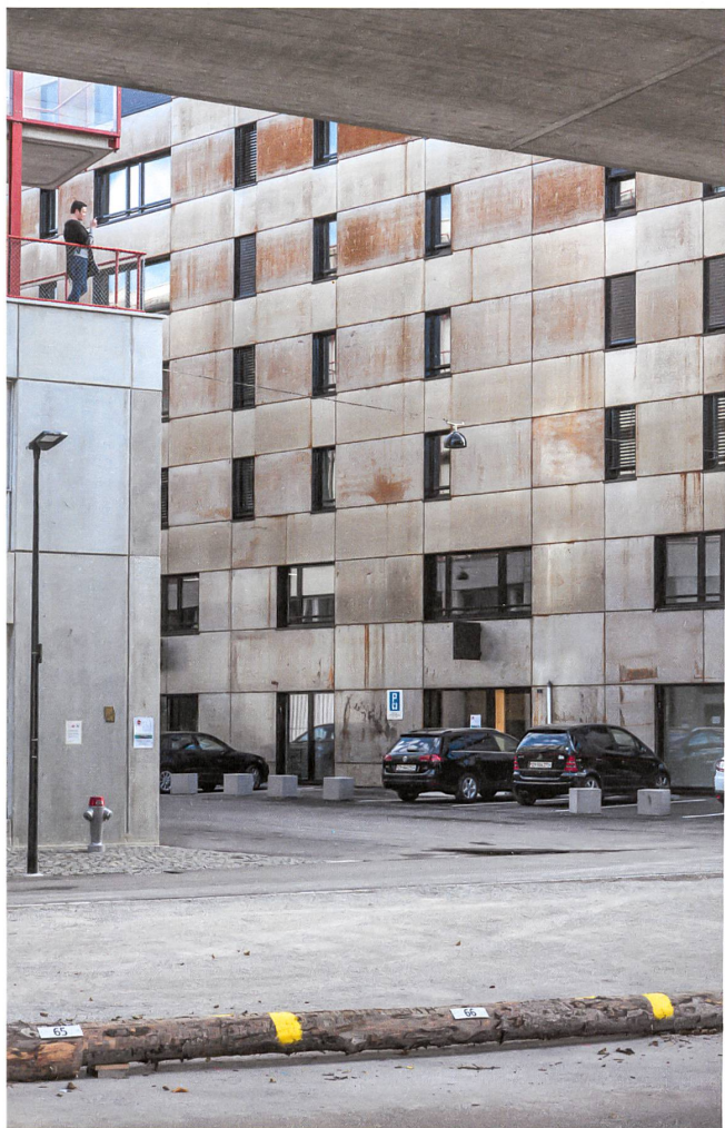
Wohnen hinter harter Schale: die rostige Fassade zum Bahnviadukt.
