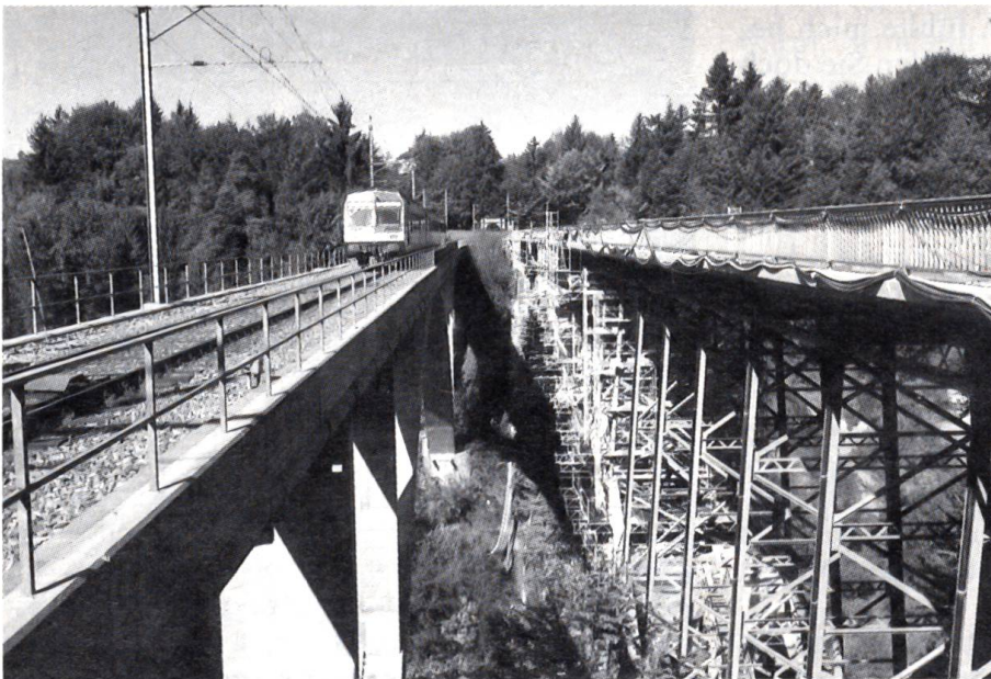
Sanierung der Schwarzwasserbrücke
