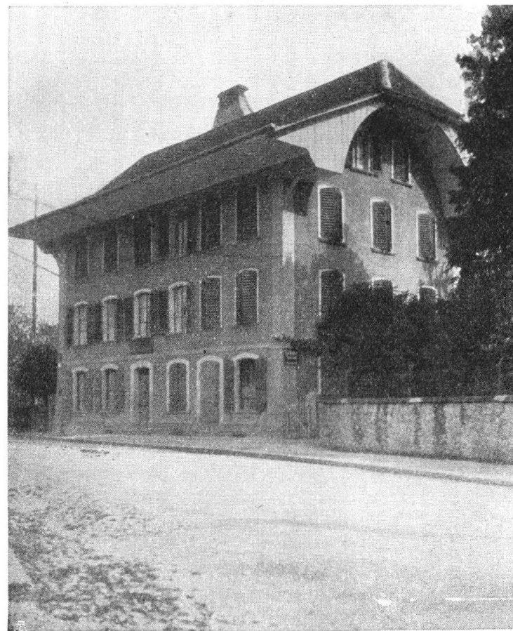
Abb. 13. Thun. Wohnhaus beim Berntor. Dachkonstruktion vom Bauernhaus übernommen. — Fig. 13. Thoune. Maison d'habitation non loin de la porte de Berne. La construction du toit dérive de l'architecture paysanne.
