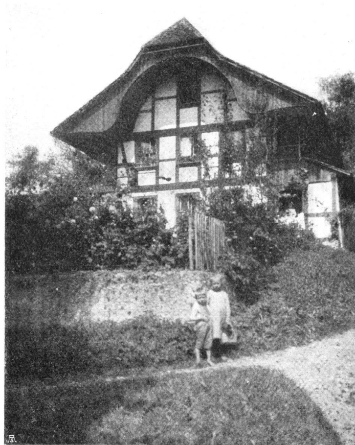
Abb. 7. Heimberg Wohnstock mit Fachwerk. Fig. 7. Heimberg. Maison d'habitation paysanne en pans de bois.
