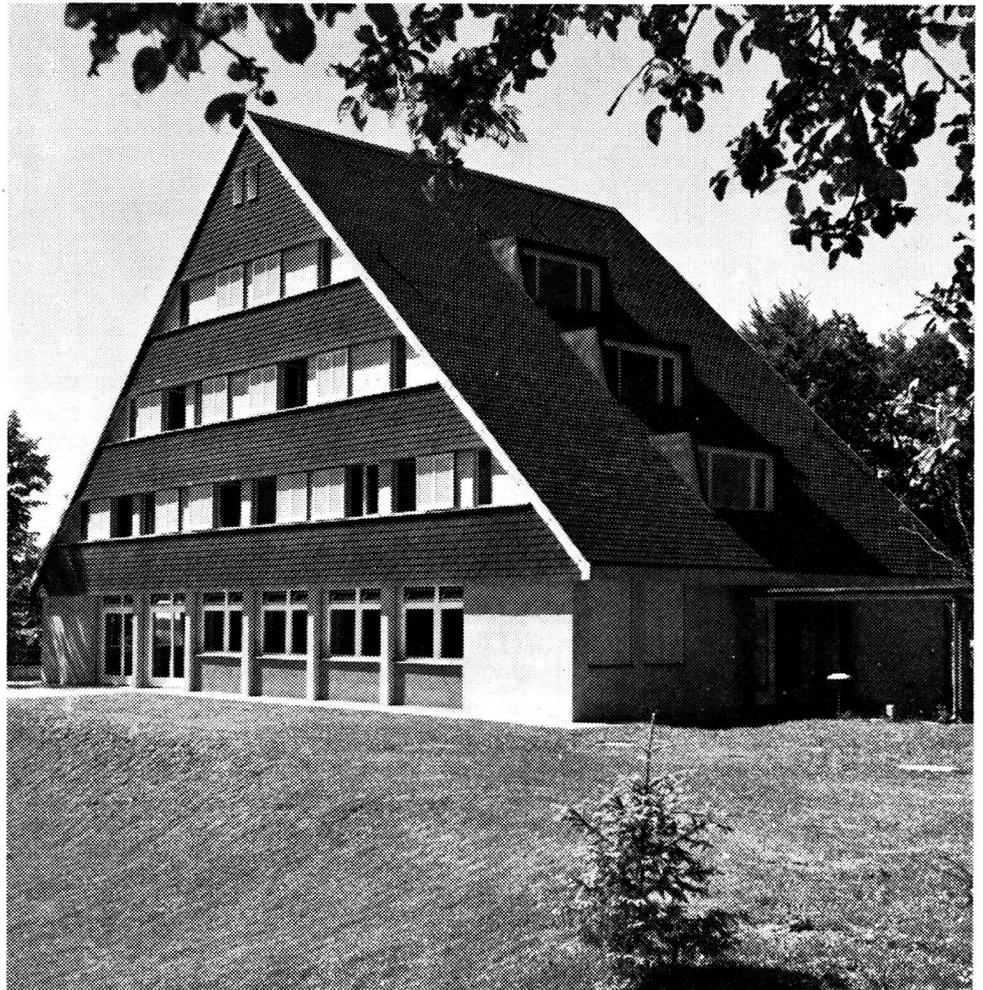
Le toit et la façade sont recouverts d'ardoises en amiante-ciment
