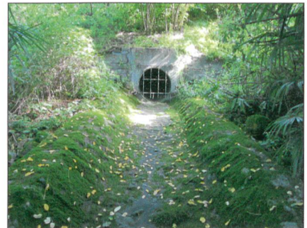
Abb. 1: Hochwasserentlastung in Gordola (Ecocontrol SA).
