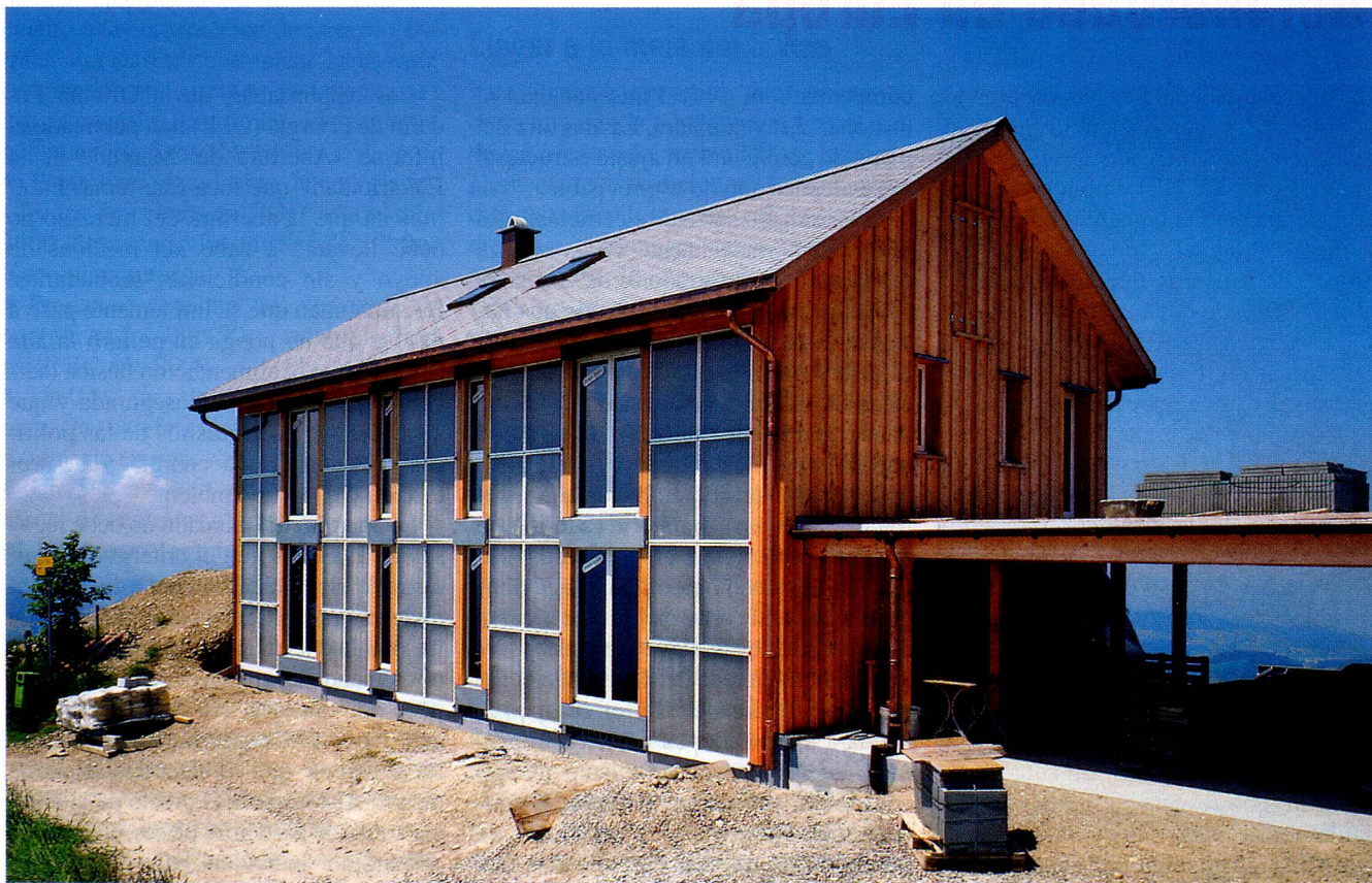
Un proyecto piloto en el cantón de Appenzel: las paredes de la fachada suministran energía solar gracias al aislamiento transparente, fruto de la nueva técnica. (Foto: Oerlikon Journalisten)
