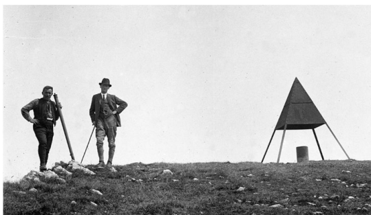
Abbildung 1: Landesvermesser auf dem Chasseral, 1921. Die «Pyramide» signalisiert den dortigen Triangulationspunkt (swisstopo Bildsammlung, Inv. Nr. 000-389-722).
