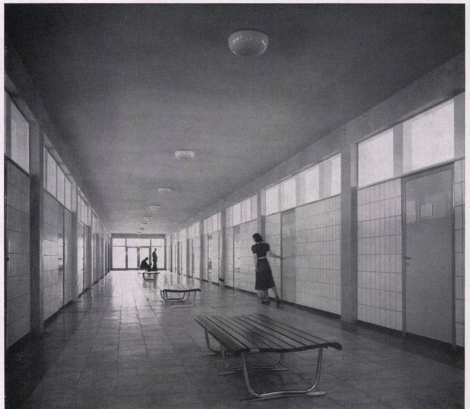
Mittelflur der männlichen Vermittlung, 4,80 m breit als Warteflur, beiderseits Lichtband, Holztüren in Stahlzargen, Wände bis Türhöhe glasierte Spaltklinker, Fußboden Kunststeinplatten.
