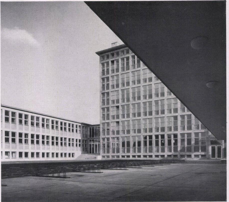
Südwestansicht des Verwaltungsbaues mit Verbindungsgang zum Versicherungsflügel. Stahlbetonskelett mit Kunststeinplattenverkleidung. Brüstungs- und Giebelfelder mit Oldenburger Klinker ausgefacht. Holzfenster mit inneren Stahlverbundflügeln.
