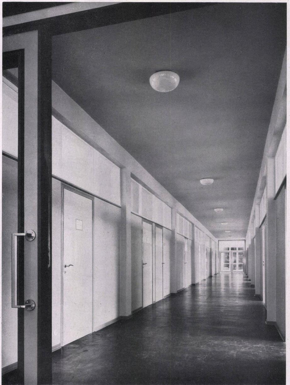
Mittelflur im Verwaltungsbau. Beiderseits Lichtband, Holztüren in Stahlzargen, Wände bis Türhöhe mit stoßfestem und abwaschbarem Anstrich, Fußboden Floorbest.
