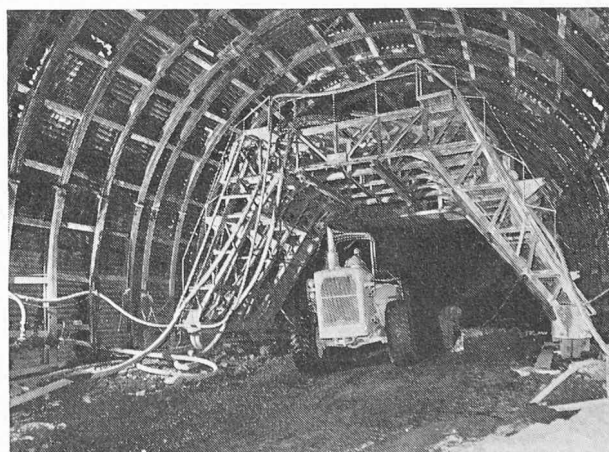
Fig. 9. — L'étayage métallique et le chariot destiné à la mise en place du béton d'étayage.
