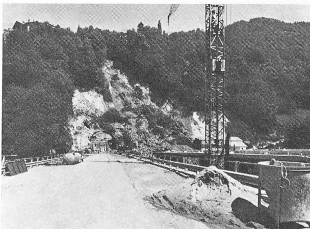
Fig. 4. — L'éboulement de mai 1968
