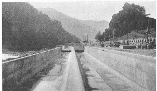
Fig. 8. — Canaux intermédiaires avec, au fond, les diaphragmes et le départ des canaux latéraux.
