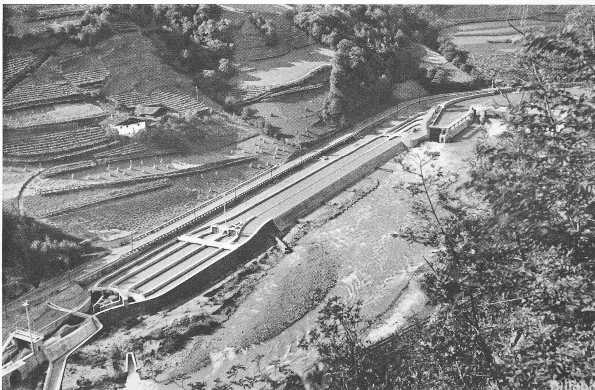
Fig. 4. — Vue sur l'ensemble de l'installation. Bassin versant du torrent env. 3000 km 2 . Débit dérivé 100 m 3 /sec.
