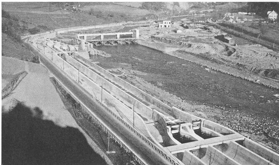
Fig. 9. — Vue sur l'entrée des dessableurs et des canaux latéraux, sur les diaphragmes, les canaux intermédiaires, avec, au fond, les dégraveurs, la prise d'eau et le barrage.
