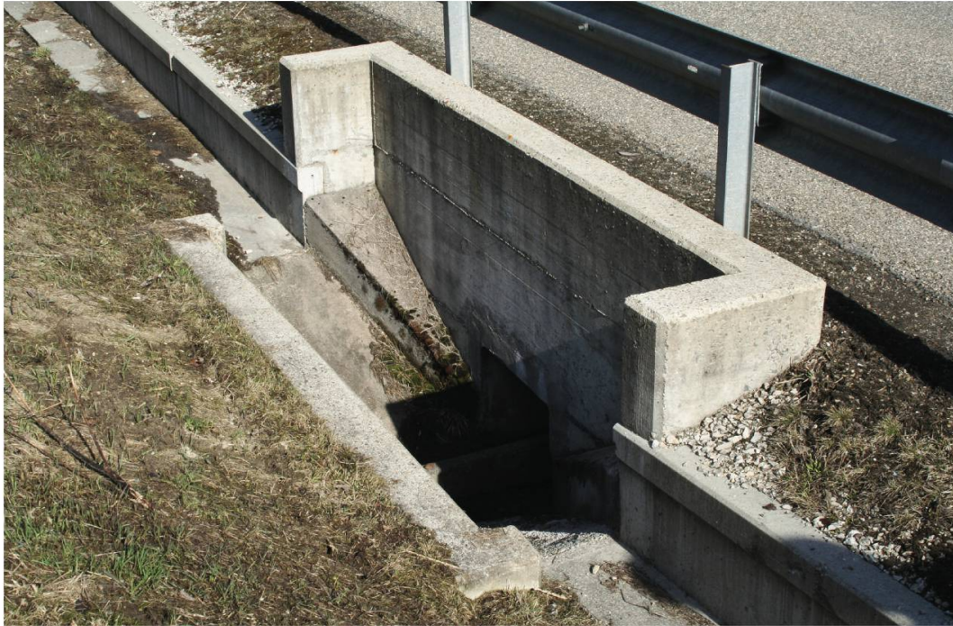
Fig. 3 : Détails de l'aménagement d'un crapauduc
