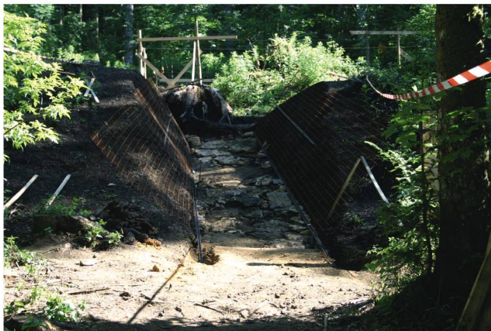
Fig. 8. Vue d'ensemble de la tranchée, où l'on aperçoit le système de stabilisation des talus.
