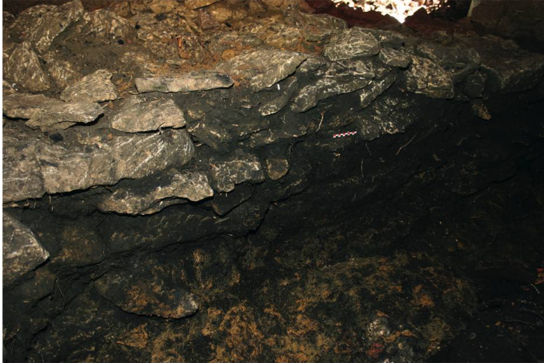
Fig. 27. Arrière de la plateforme : vue du parement solidement construit.
