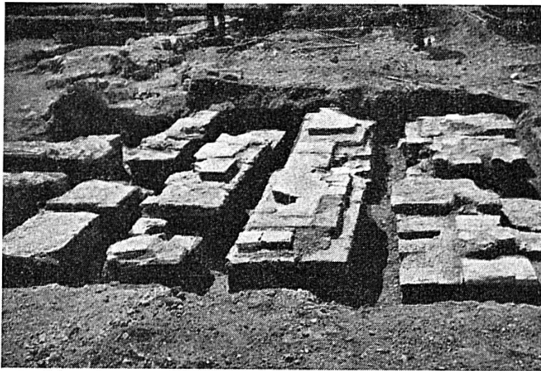
Fouilles de Vicques : Vue du chauffage des bains
