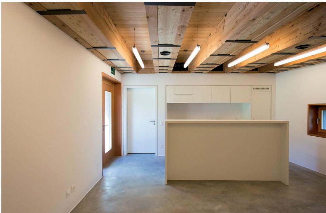
La struttura del solaio in legno è disposta longitudinalmente all'edificio per consentire l'installazione delle condotte dell'impianto di ventilazione-riscaldamento.
