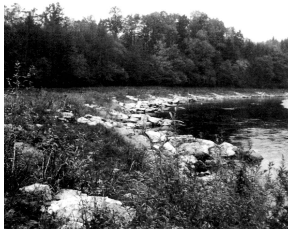
Links: Die Bühnenstrecke flussabwärts nach einer Vegetationsperiode.
