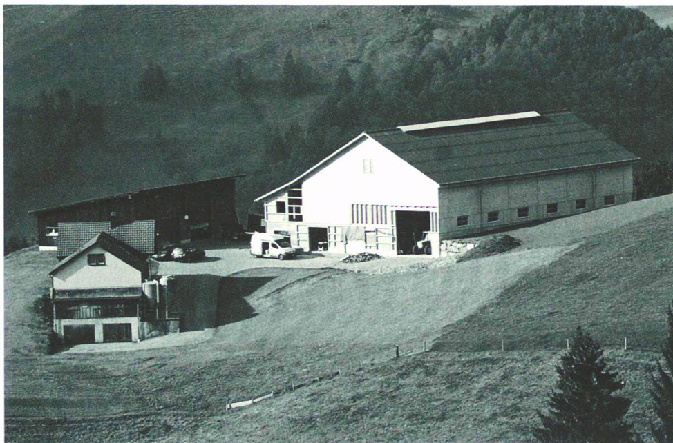
Fertigstellung des ersten Innerrhoder Modellstalls auf dem Oberhof im Bezirk Schlatt-Haslen.
