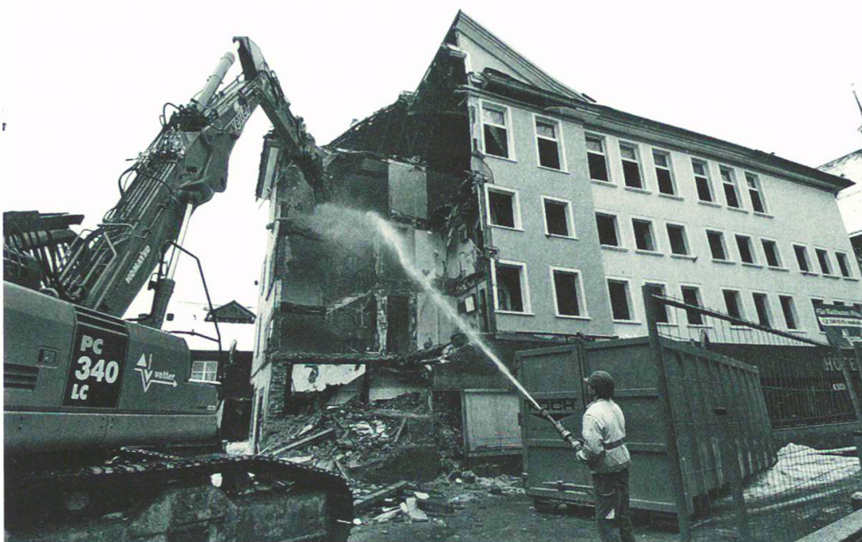
Abbruch des Hotels Krone in Appenzell.
