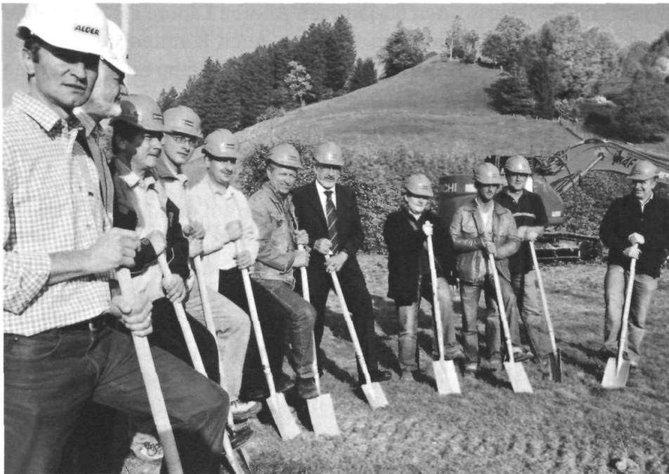
Spatenstich am 9. April für den Umbau und die Erweiterung der Schulanlage Sommertal.
